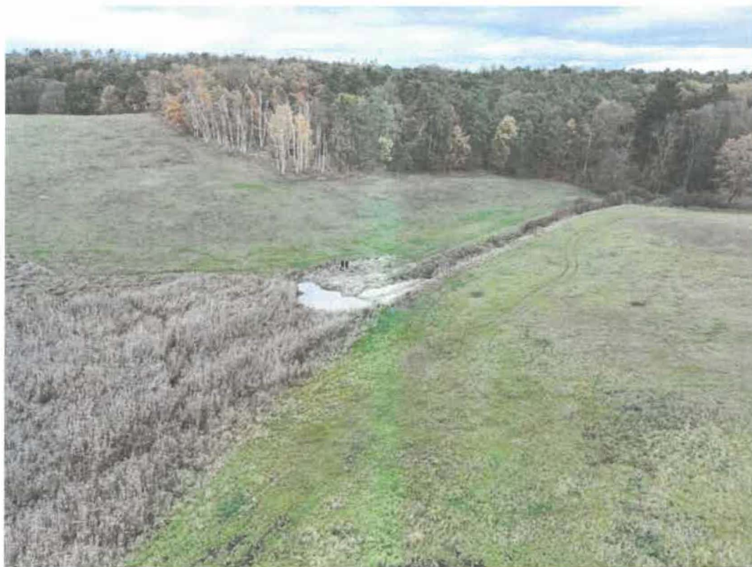
Abb. 2: Erster Bauabschnitt der Renaturierung des Gellmersdorfer Grabens (Fotot: L. Schulz)
