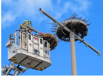
Nisthilfenbau für Störche in Schwedt
