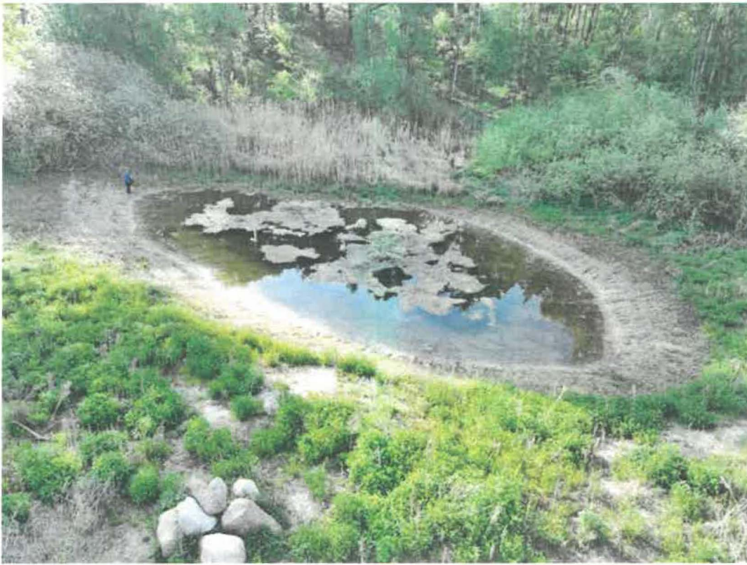
Abb. 11: Maßnahmenfläche M30, Waldsoll (Foto: L. Schulz)
