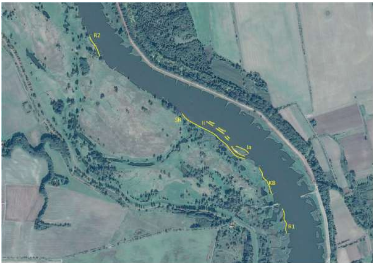
Abb. 2: Lage der Befischungsstrecken im Bereich der Instandsetzungsmaßnahme in der Oder bei Reitwein vor Baubeginn (R1, R2= Referenzstrecken, SR= Stromrinne, KB= Kerbbuhne, li, la= Innen- und Außenseite der Inseln).
