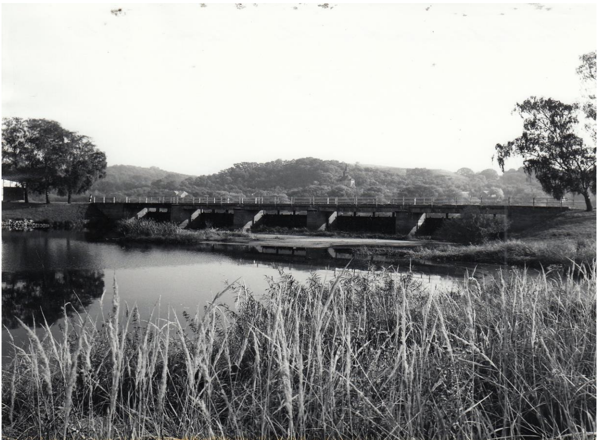
Einlassbauwerk an der "Unteren Oder"
