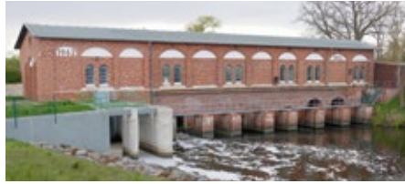
Das Schwedter Pumpwerk (Fotos: A. Vössing)
