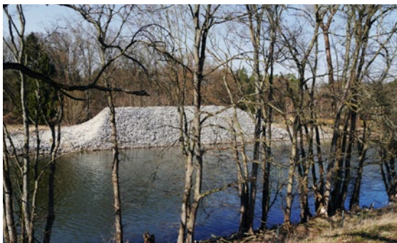
Materiallager (Steinschüttungen) für den Gewässerausbau neben der Wildnisschule Teerofenbrücke im Herzstück des Nationalparkes (Foto: A. Vössing)
